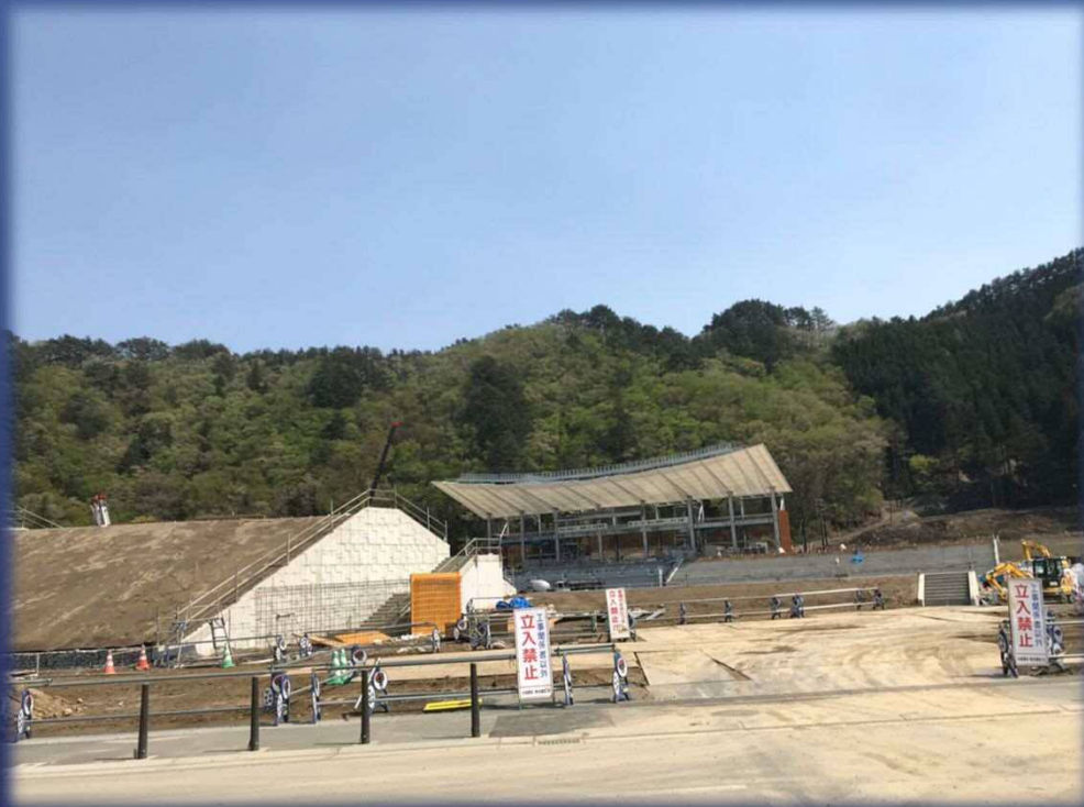
復興スタジアム建設中
