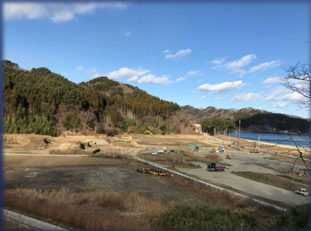
多目的広場造成状況
