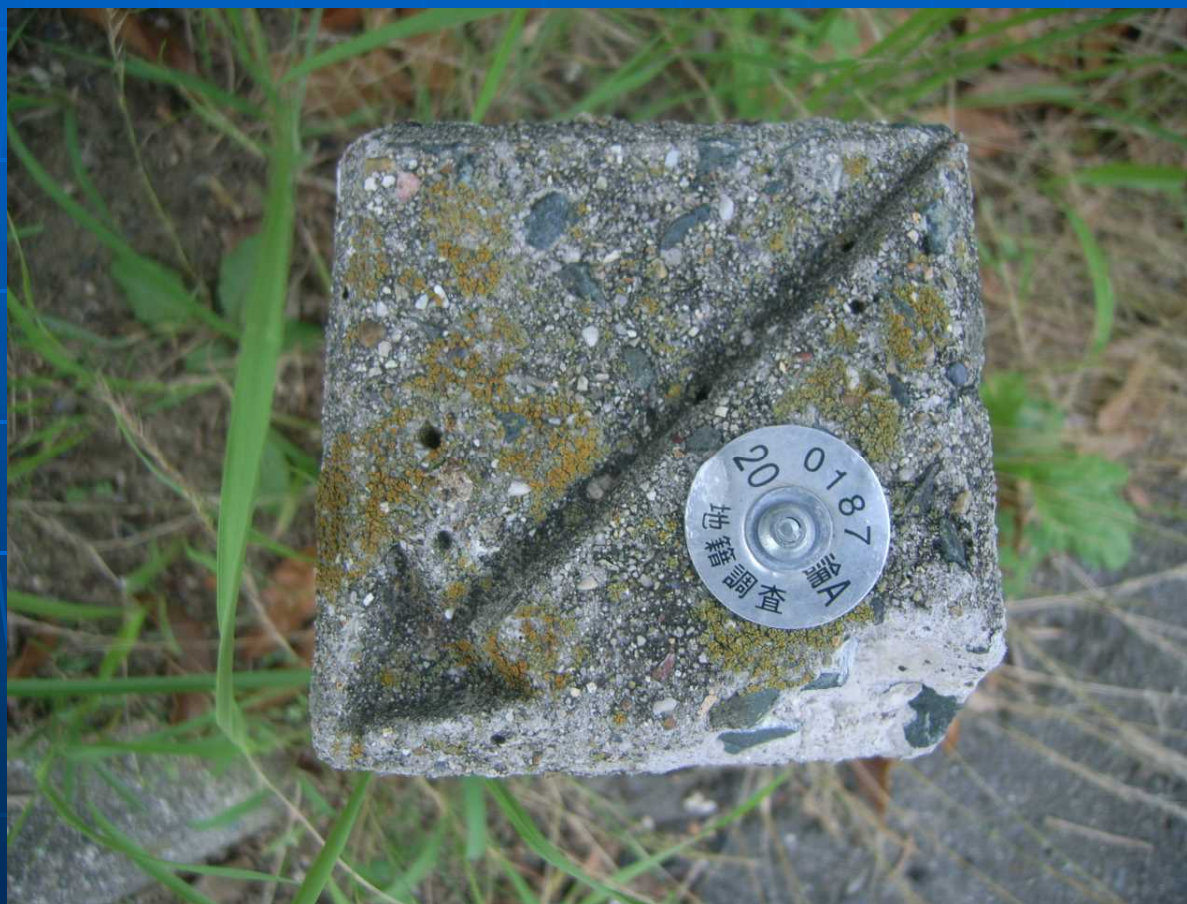
既存コンクリート杭
