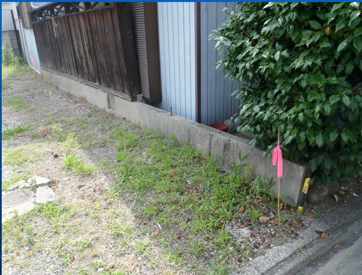
目印テープ設置風景
