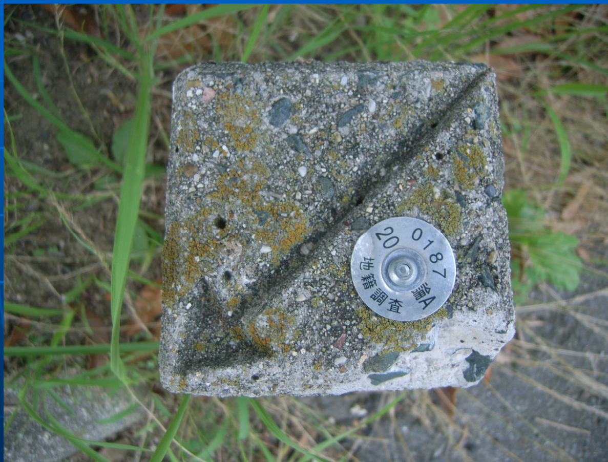
既存コンクリート杭
