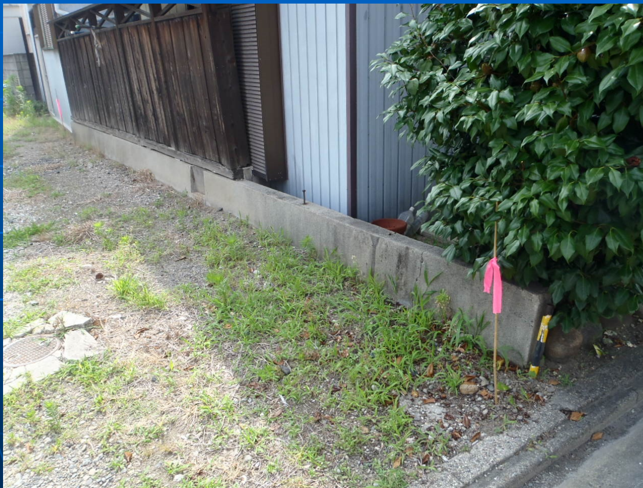
目印テープ設置風景
