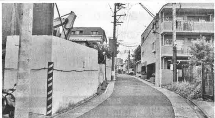
建設地では現在、既存建物の解体が進んでいる。
